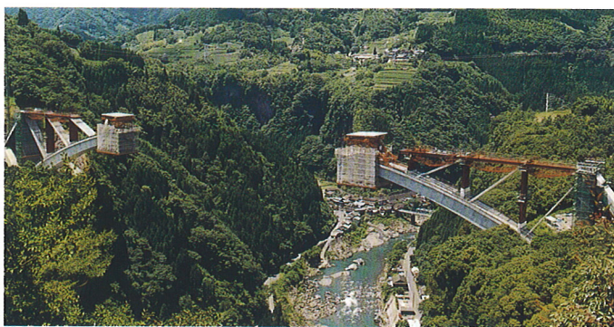
トラベラーによる張出し施工
