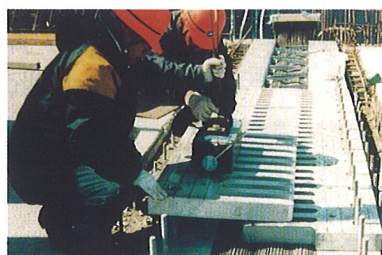
フェースプレートの取付け
