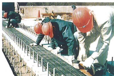
防水ゴムの設置
