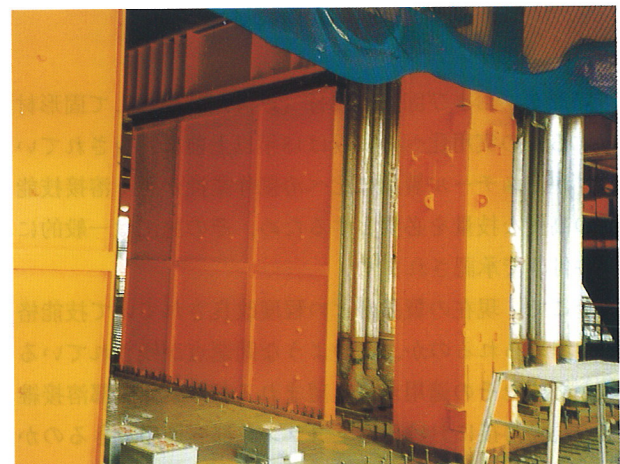
制震壁設置写真
