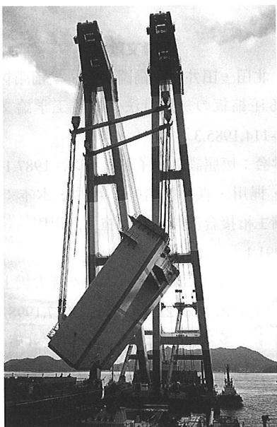
写真5 塔下部大ブロック架設状況
