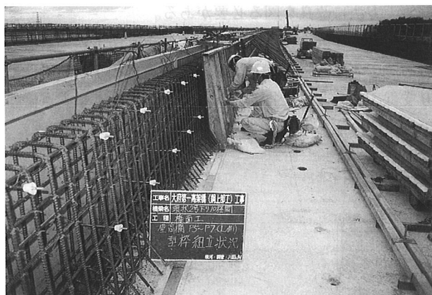
写真7 壁高欄施工状況
