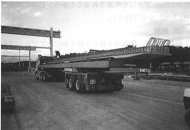
写真2 PCa床版運搬状況
