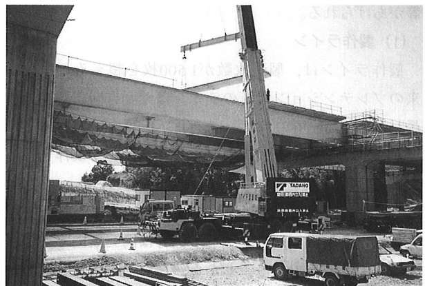
写真3 桁下架設
