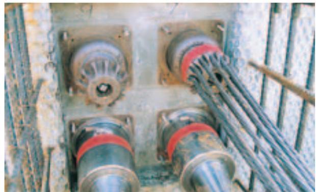
施工状況（左 / PC鋼材配置前、右 / PC鋼材配置）
