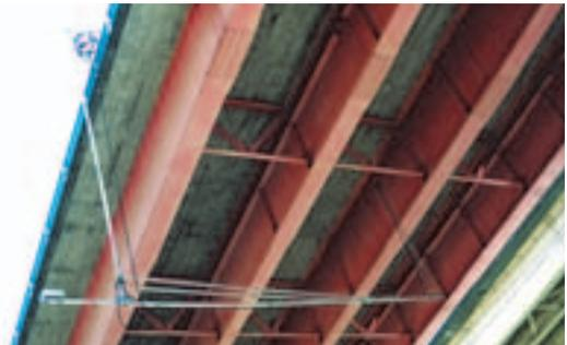
写真4 床版下面の点検状況
