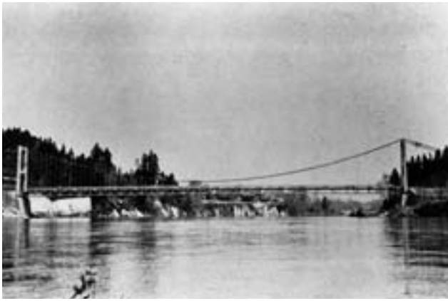
写真1 機能的寿命26年の西羽賀橋
