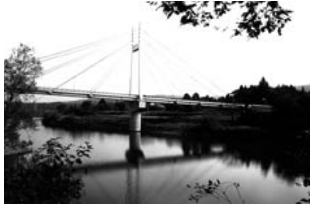
写真2 架け替え後の西羽賀橋
