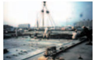
鋼工桁橋 (PCa PC床版)
