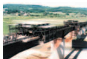
連続合成桁の鋼少数主桁橋(変断面桁を押し出し施工)
