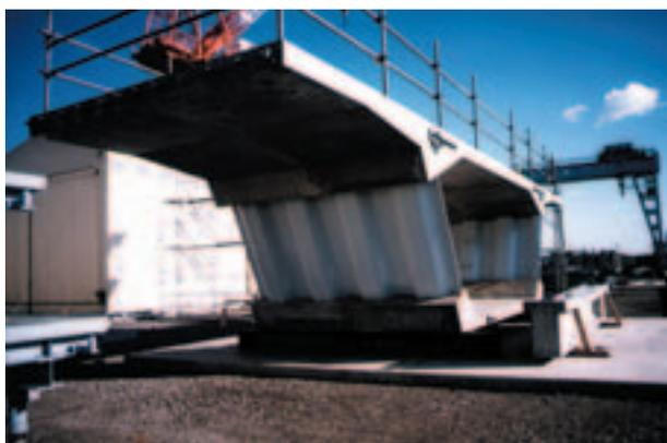
写真3.2 波形鋼板ウェブ橋
