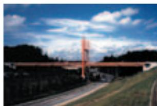
PCa床版を用いた合成桁
