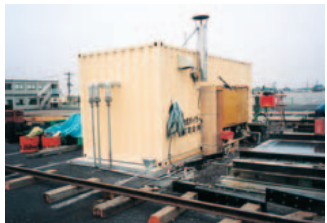
コンクリート蒸気養生
