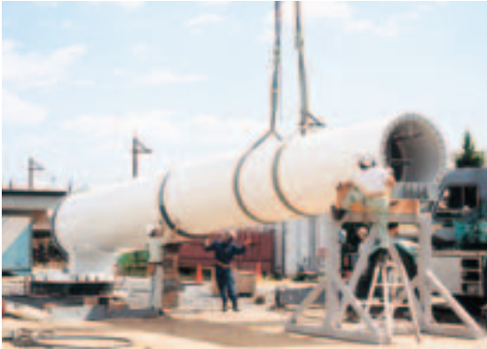
2. タワー架設写真
