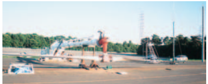
実験計測用風車の改造完了写真
