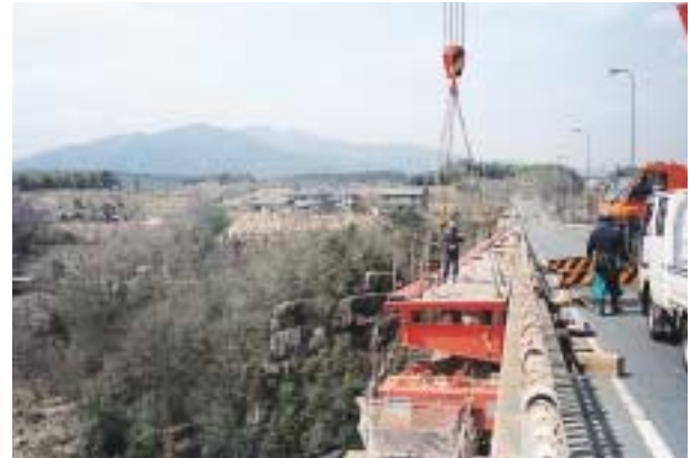
ローゼ桁部歩道架設
