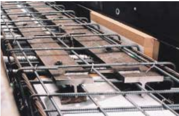
主桁製作状況
