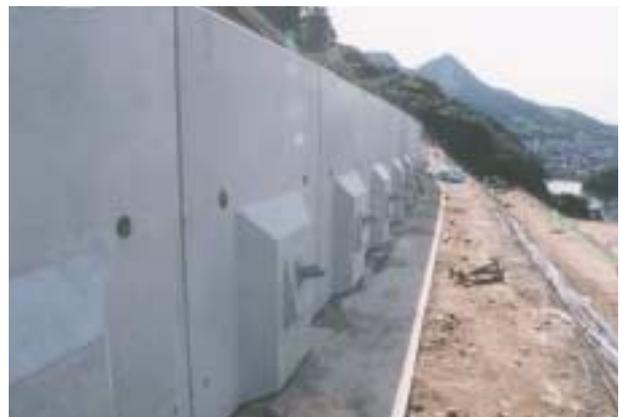
受圧板設置・アンカー工完了
