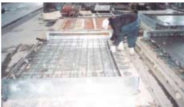
b) 上側鉄筋の配筋の状況
