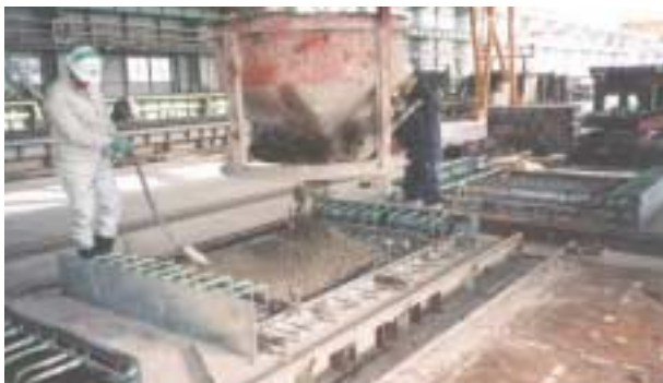
c) コンクリート打設の状況
