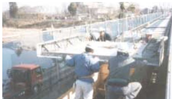
写真2 床版の設置状況
