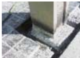
写真2 施工中の防護柵基部
