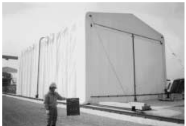
写真6 コンクリート養生上屋
