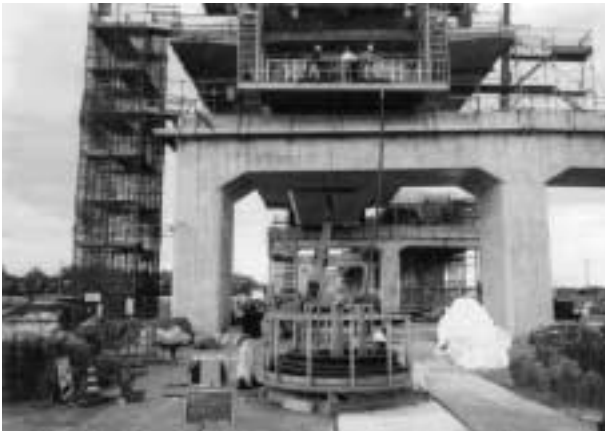
写真12 外ケーブルの引込み
