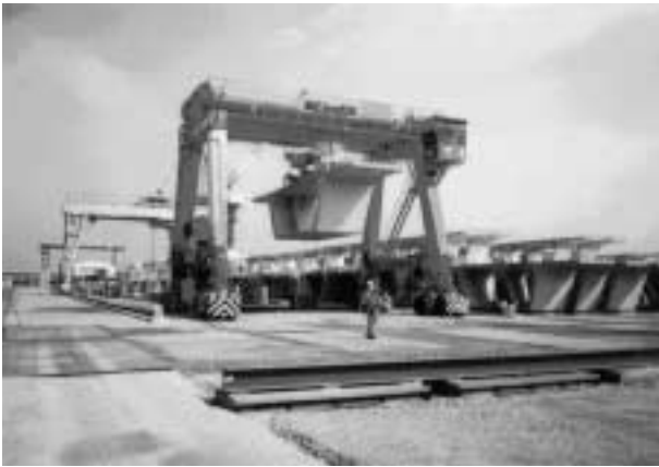
写真7 トランスファークレーンによる運搬
