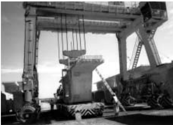
写真8 柱頭部セグメント積み込み
