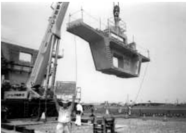
写真9 柱頭部セグメントの架設
