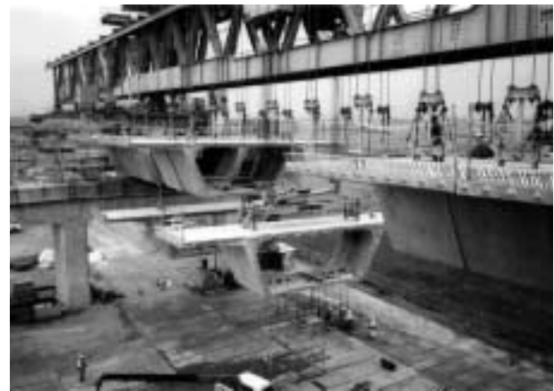
写真10 架設機によるセグメント架設
