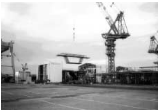
写真4 鉄筋籠吊り込み
