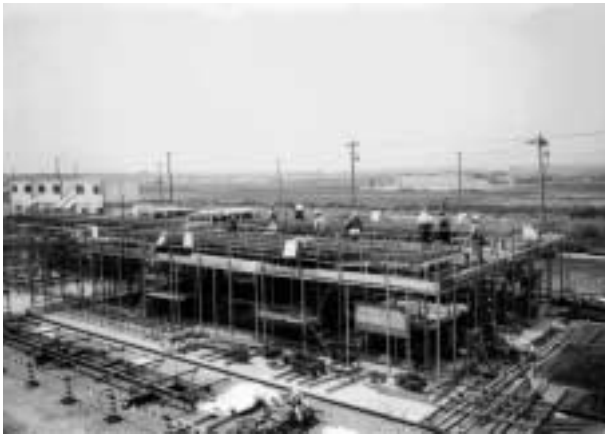
写真3 鉄筋組立架台
