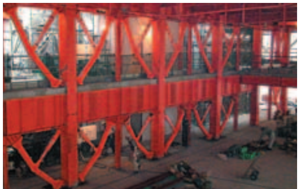
トグル数140基 2002年12月竣工 日本大学理工学部1号館
