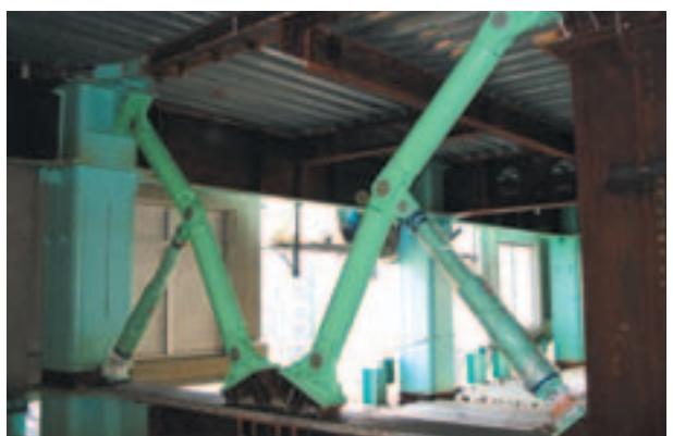
トグル数208基 2003年12月竣工予定 都市整備公団川崎駅西口ビル
