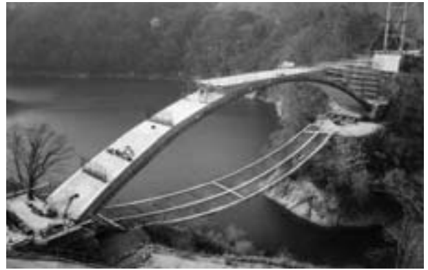
写真5 メラン材巻立て完了時
