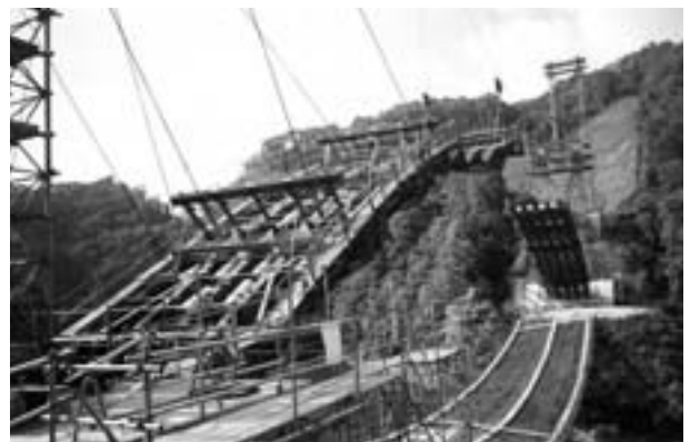
写真1 メラン材架設状況
