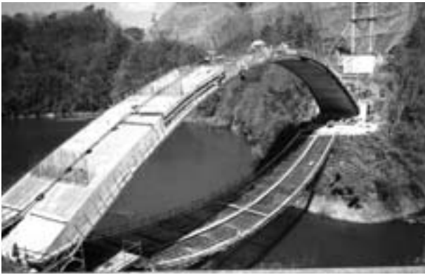
写真4 コンクリート巻立て状況
