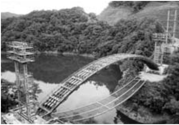
写真2 メラン材架設完了時
