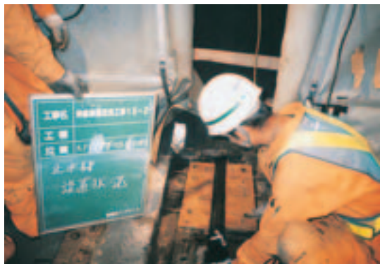
写真2 伸縮装置取り替え工事(夜間)止水ゴム設置
