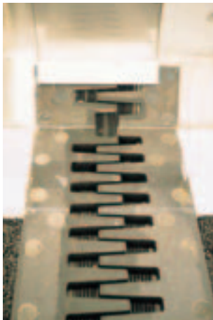
写真1 止水ゴム設置状況
