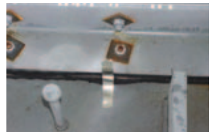
c) ステンレステープによる固定状況
