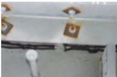
a) 導水装置端部の状況
