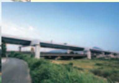
中間支点部は、横梁との剛結構造となっている。桁下に橋梁が存在するため大型クレーンによる一括架設および送り出し架設を行っている。本橋により、伊予大州～鳴門間が全通し京阪神方面へのアクセスに大いに利用されることになる。
