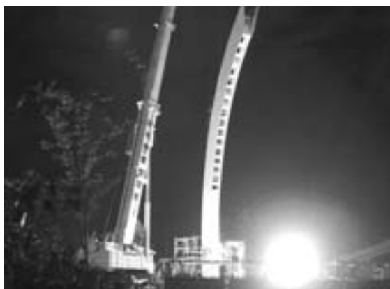
写真7 高塔地組立ブロック架設状況
