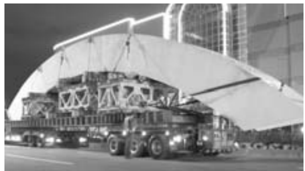
写真6 地組立ブロック運搬状況
