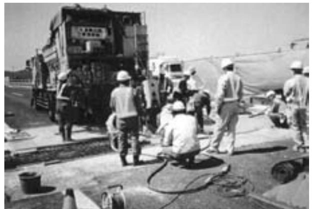
写真4 超硬コンクリートの打設状況
