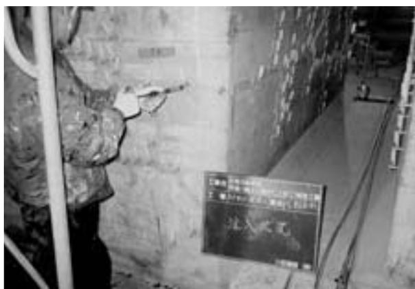
写真7 ひび割れ注入状況（柱頭部）
