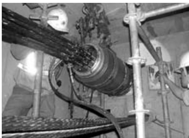
写真6 外ケーブルの緊張状況
