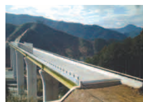
普及が進むSCデッキの架設状況、完成状態
