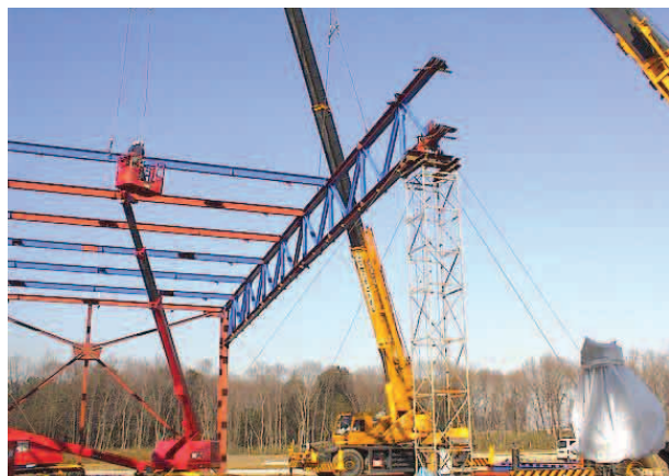
仮設柱へ大梁建方状況
