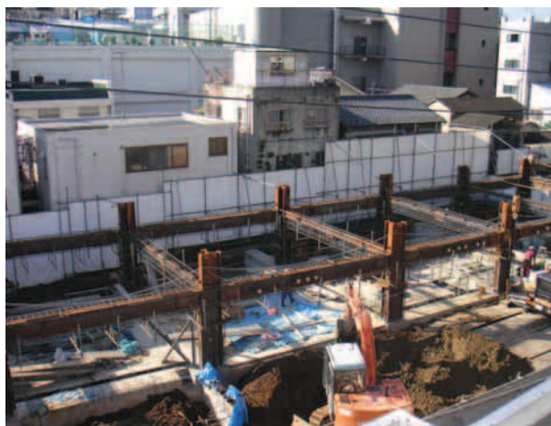
埋め戻し状況
