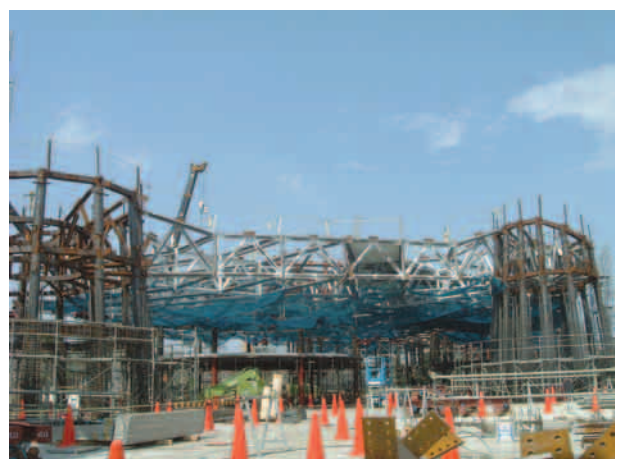
文化施設ゾーンセンター施設（建設中）
