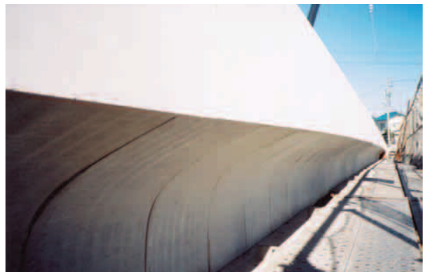
写真9 張出し床版施工状況（外面）
