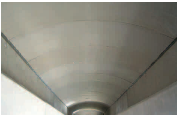
写真7 中間床版完成（下面）
