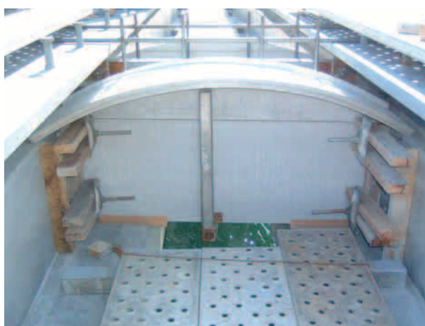
写真6 横桁部の施工状況
