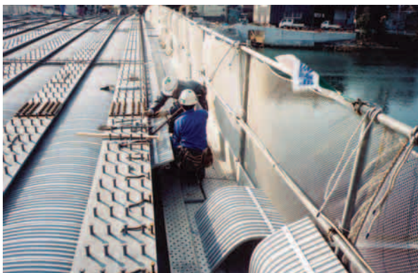
写真8 張出し床版施工状況
