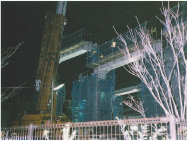
写真4 縦梁の架設状況
