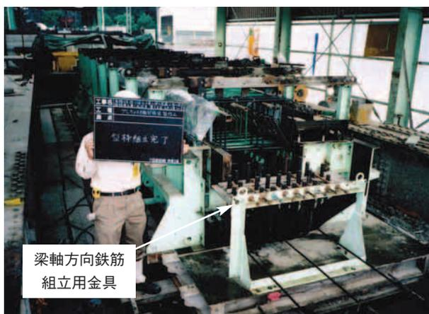
写真1 工場における鉄筋・型枠組立状況（横梁）
