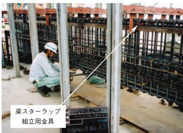
写真2 工場における鉄筋・型枠組立状況（縦梁）
