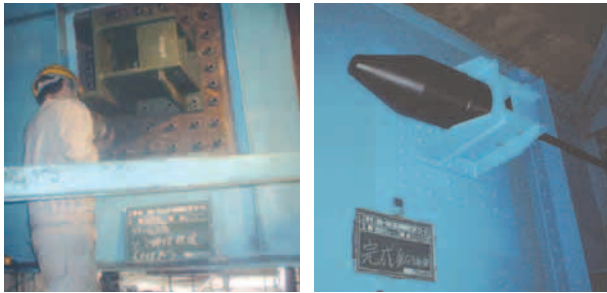
写真5 落橋防止ブラケット取付および完成
