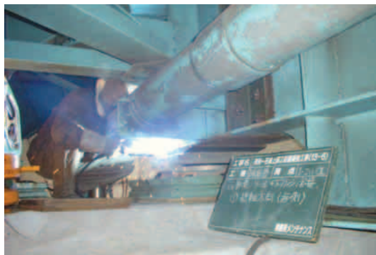
写真3 支承現場溶接
