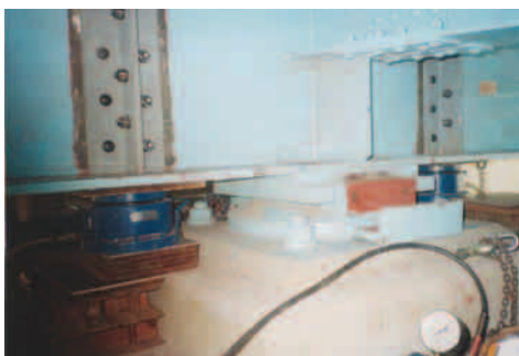
写真2 ジャッキの設置例
