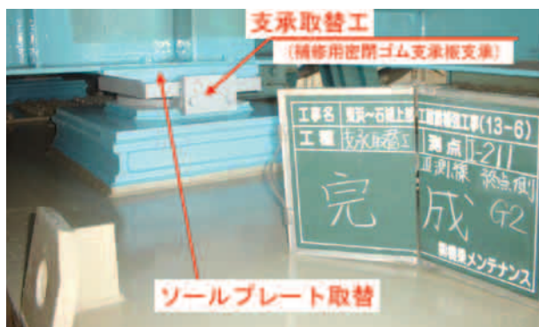
写真4 支承取替完成
