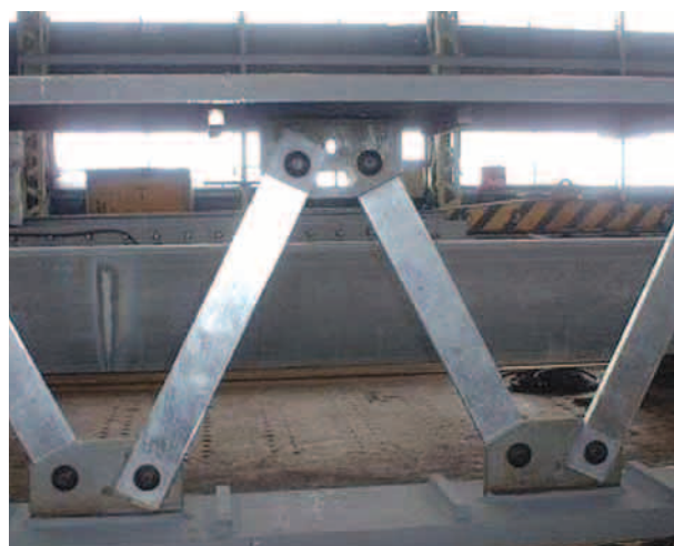
写真5 鋼げた部の製作状況 (その2)
