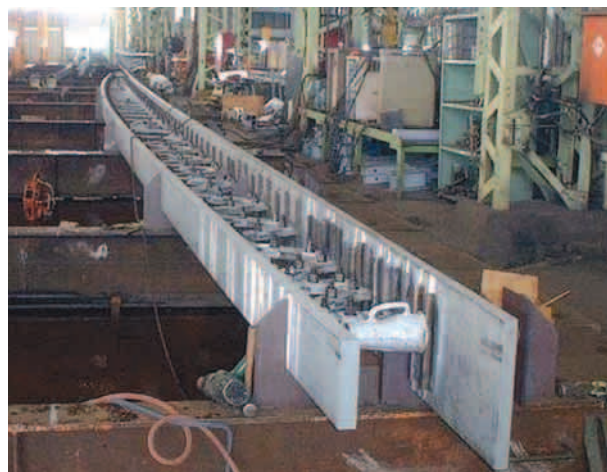
写真4 鋼げた部の製作状況 (その1)
