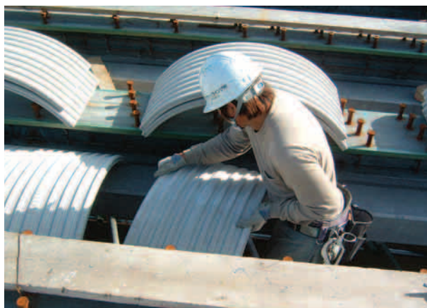
手作業による敷設状況
