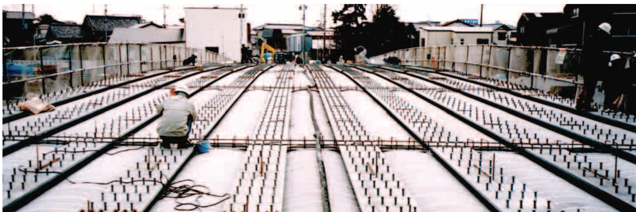
アーチフォーム敷設完了状況
