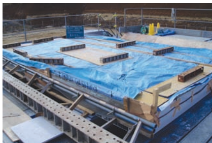
実験での養生状況
