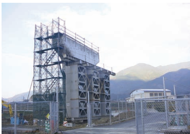
支柱組立完了
