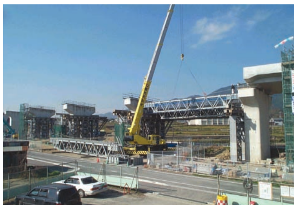
トラス梁架設状況
