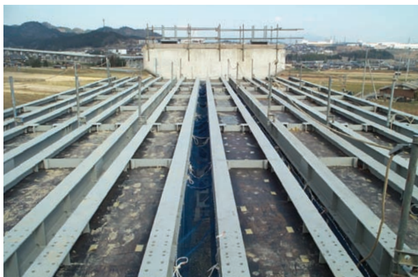
トラス梁架設完了全景
