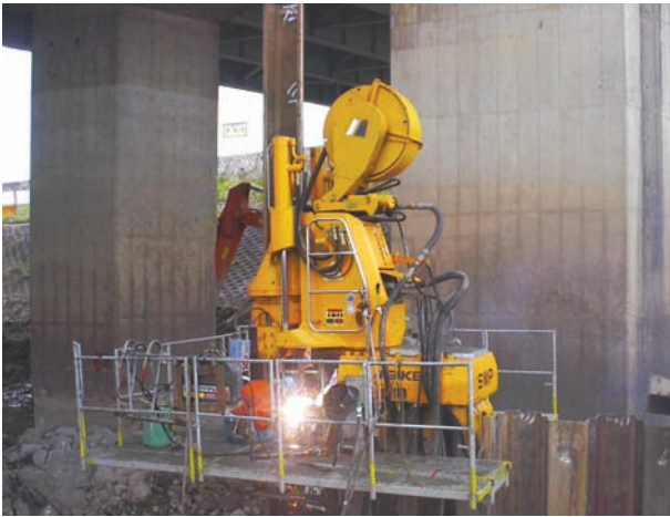
油圧式圧入機による鋼矢板の圧入作業状況
