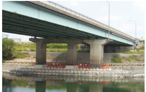
出水期に入るまでの作業を完了した状況
