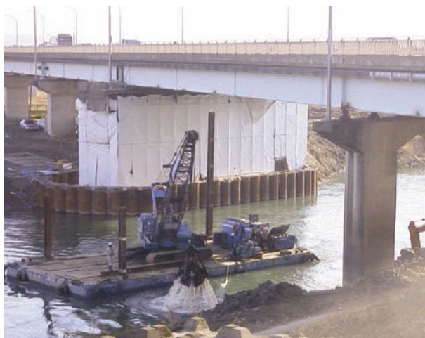
クラムセルによる捨石の撤去状況
