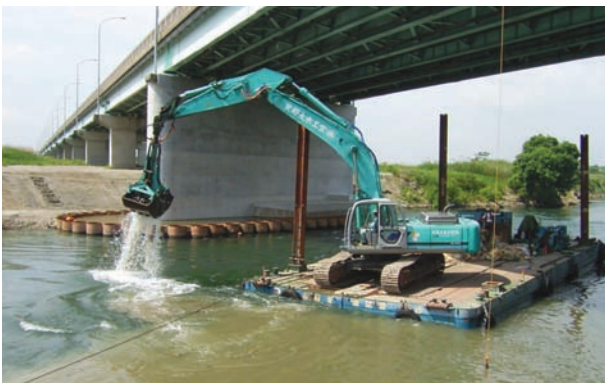
押さえ盛土撤去 (1.2 m 3 級バックホーによる水上施工)
