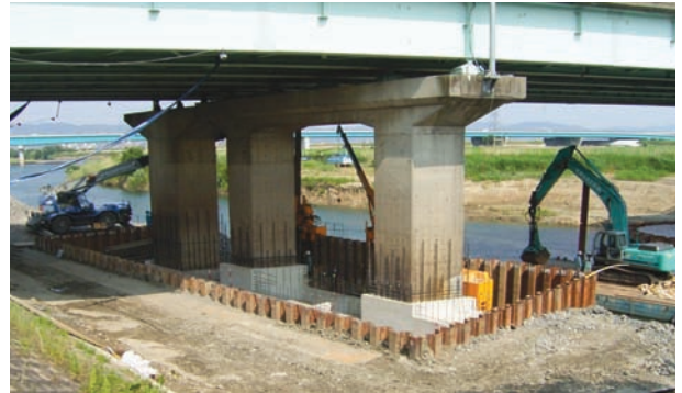
地中部の補強工事が完了し仮設物の撤去前のP1橋脚
