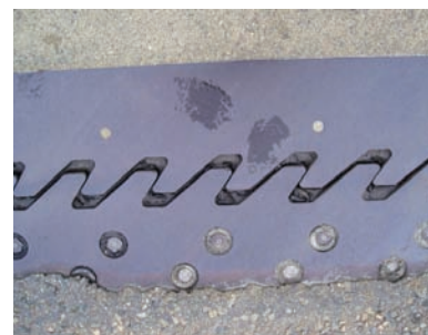
着手前（伸縮装置表面）
