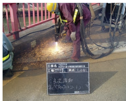
アモルファスコート溶射状況
