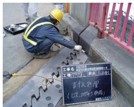
封孔処理材塗布状況
