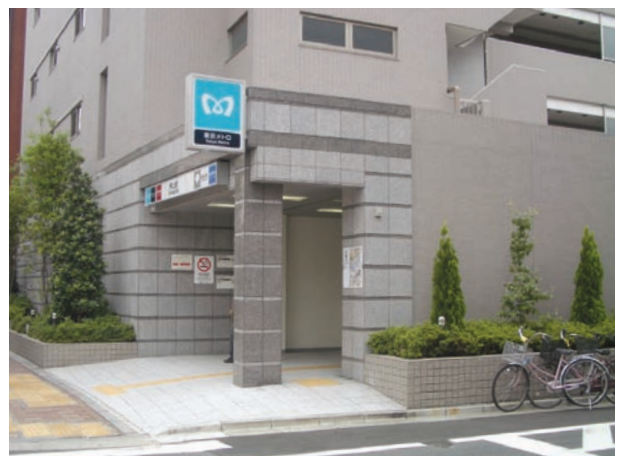
写真2 半蔵門線B2出入口竣工
