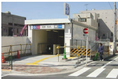
写真1 工事着手前地下鉄出入口
