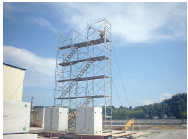
写真2 目地部止水確認試験
