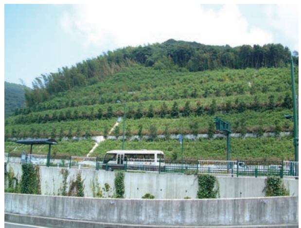
写真3 工事完成より1年半後
