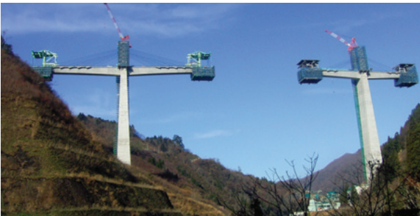
主桁ブロック張出施工状況
