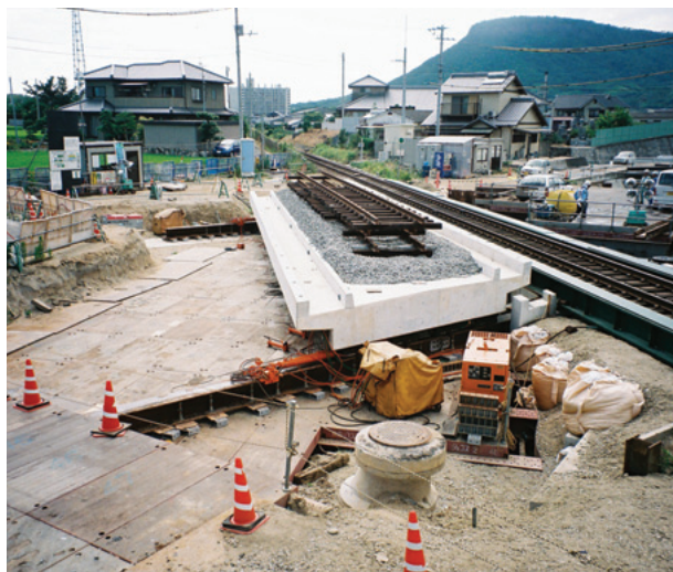
一次移動完了後
