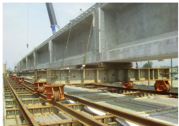
写真5 架設桁上で接合された主桁
