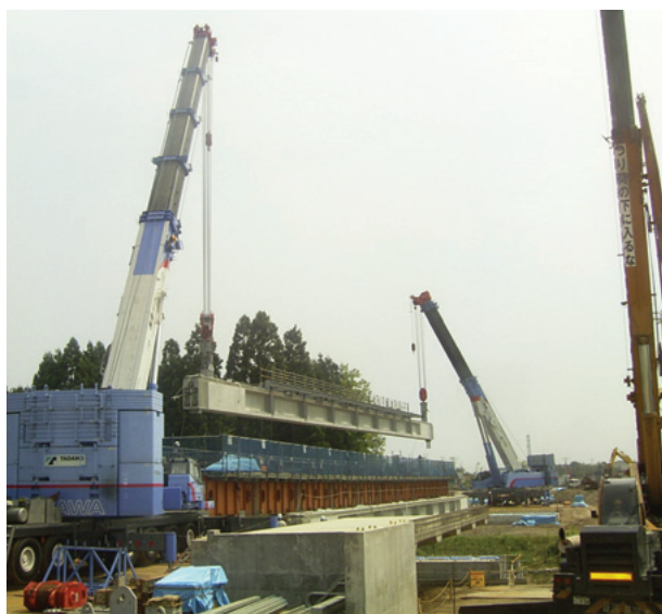
写真1 里見丸山線 主桁架設状況
