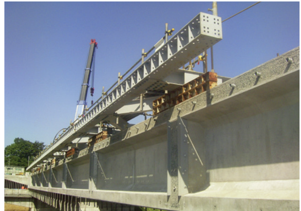
写真4 主桁に取り付けられた補剛材
