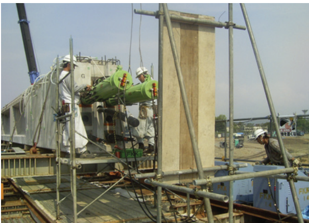
写真2 鋼材の同時緊張状況
