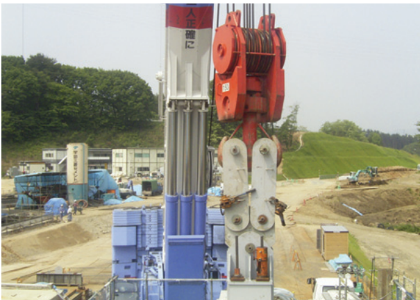
写真3 主桁吊り金具
