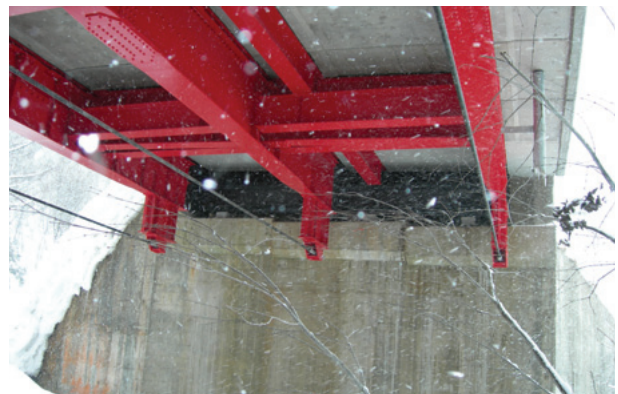
主桁補強・床版架設完了（橋梁下面より）
