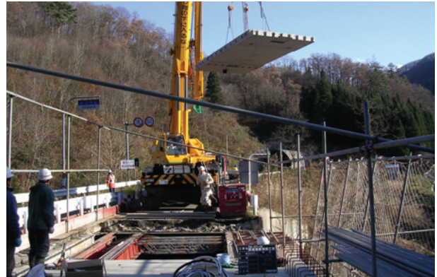
プレキャストPC床版架設
