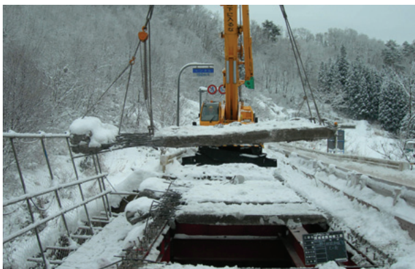
既設RC床版撤去
