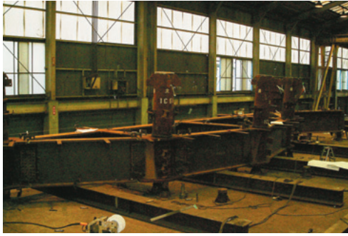
工場での仮組立作業
