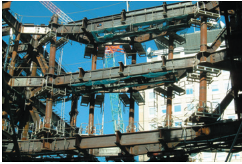
空中に浮く3階床が上階を支える
