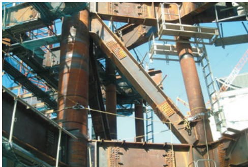
CFT鋼管柱と議場床の納まり
