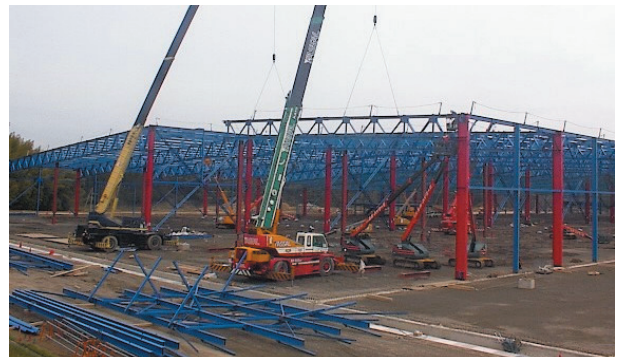
鉄骨建方状況
