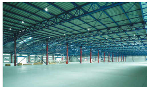
区画壁のない広々とした工場内観
