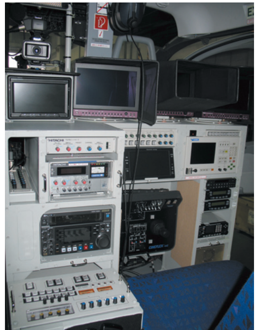
写真5 フォワードラック部操作盤
