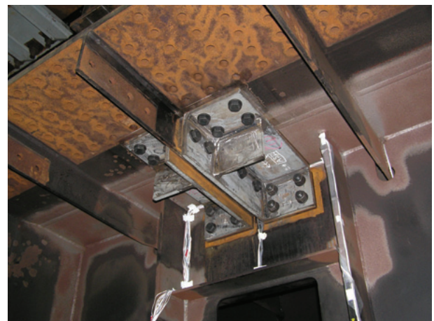
写真3 タイプ1き裂に適用した補修・補強策
