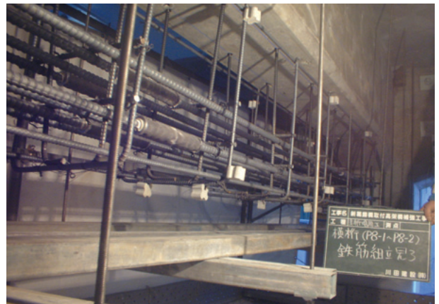
写真10 鉄筋、吊り型枠の設置
