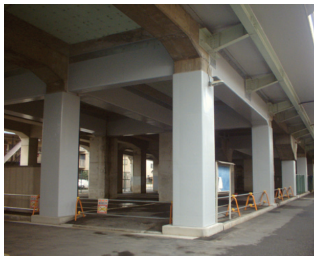
写真12 主桁，横桁増厚工完成
