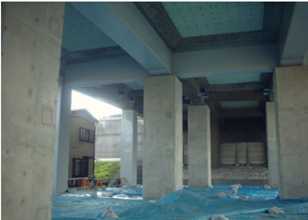
写真7 RC巻立て工完成
