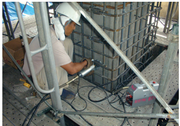
写真5 機械式継手施工状況
