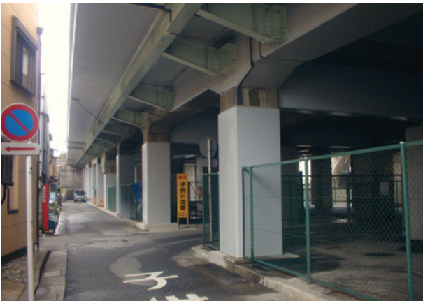
写真9 鋼板巻立て工完成
