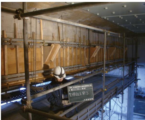
写真11 吊り型枠，打設口設置状況
