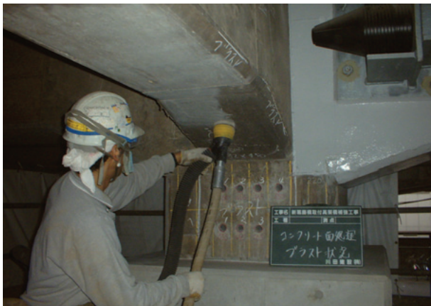
写真4 バキュームブラスト施工状況
