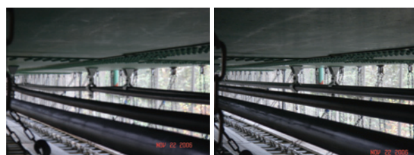
a) 緊張前 b) 緊張後 緊張作業前後のケーブルの形状
