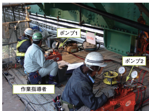
緊張作業状況
